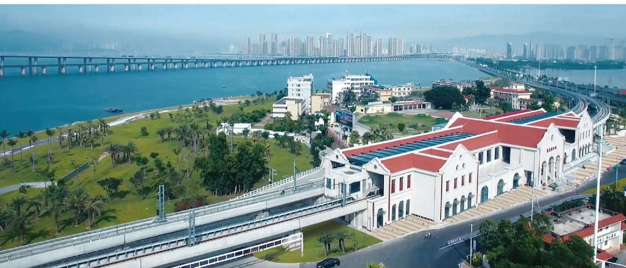
厦门地铁 1 号线 Xiamen Metro Line 1
