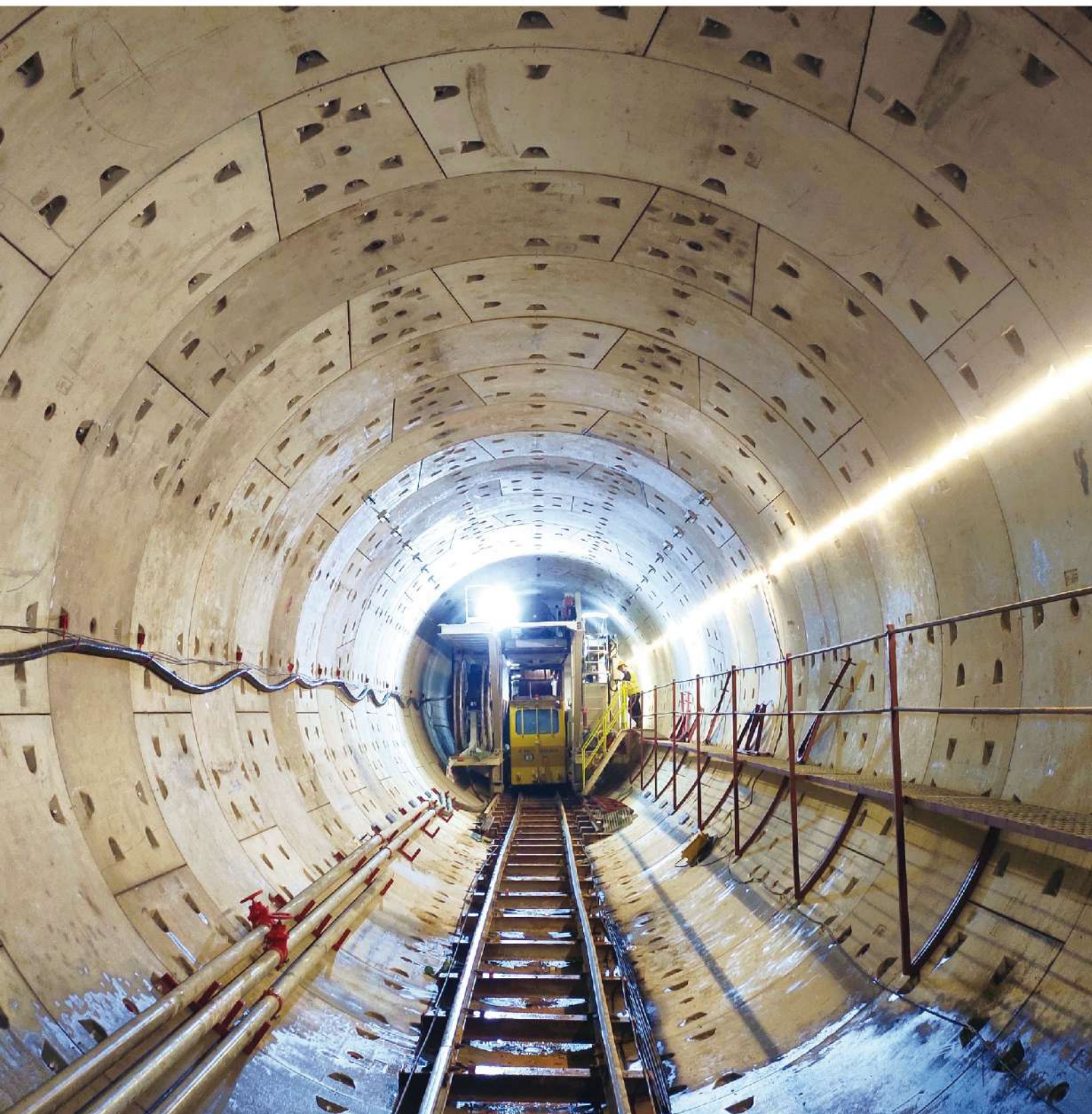
广州地铁 12 号线 Guangzhou Metro Line 12
