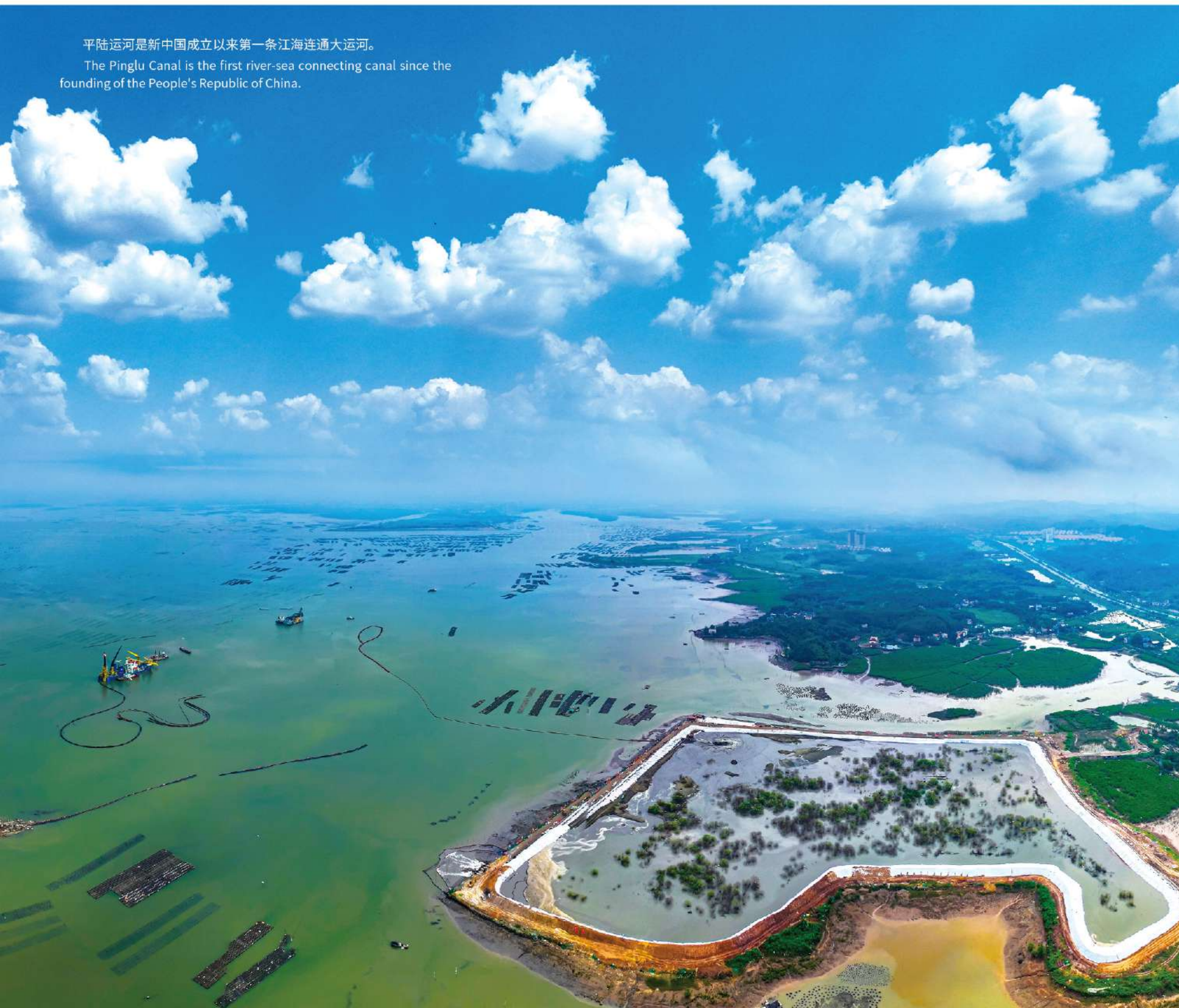
平陆运河 Pinglu Canal
