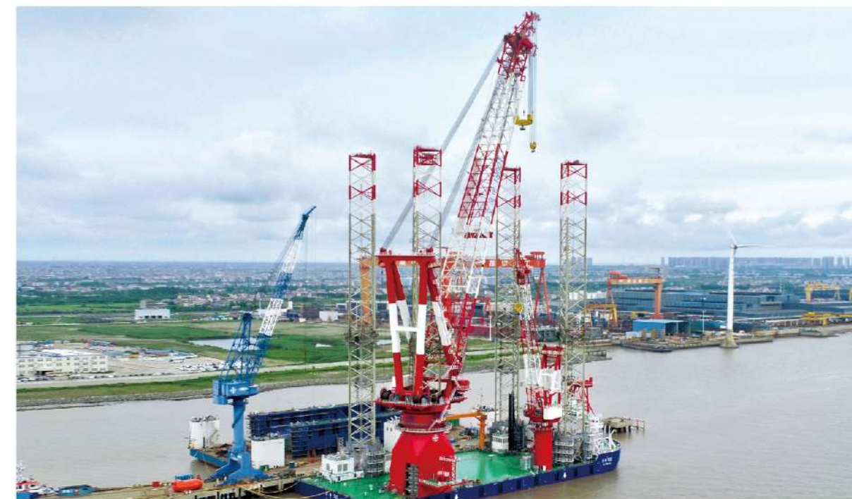
“海峰1001” 2500 吨自航自升式海上风电安装平台
