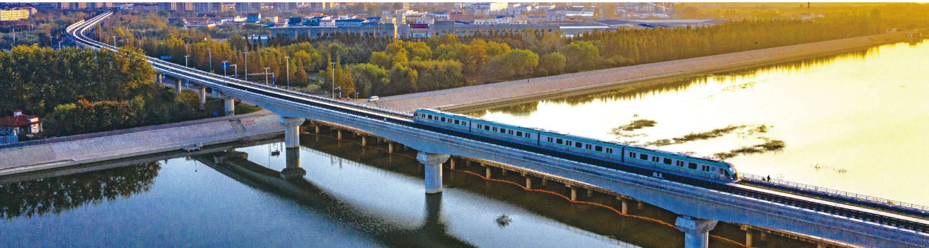
青岛地铁 13 号线 Qingdao Metro Line 13
